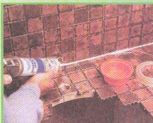
Шов у стены заполняют эластичной уплотнительной массой.
