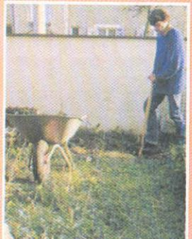
По шнуру производят выемку грунта на глубину 20 см. Если требуется дренажный слой, глубина траншеи должна составлять 25 см.
