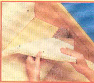
При снятии ковра следует обратить внимание на состояние крепежных реек или полос клейкой ленты. При смещении ковра вниз ширина подворота в верхней его части уменьшается.
