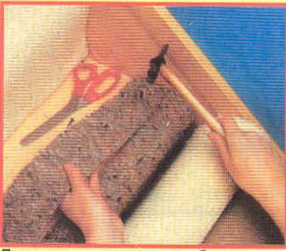
Пространство под ковром, образовавшееся в результате уменьшения ширины подворота, заполняют полосой ваты или нетканого материала, прикрепляемой к проступям на kleю или гвоздях.
