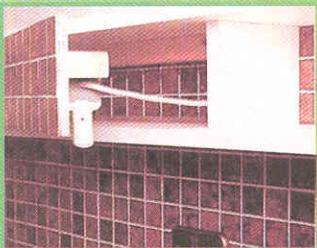
Люминесцентный светильник идеально подходит для установки над кухонным рабочим столом, поскольку он почти не излучает тепло.
