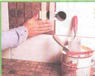
Плитку следует укладывать так, чтобы слева и справа можно было прикрепить вставки одинакового размера.
