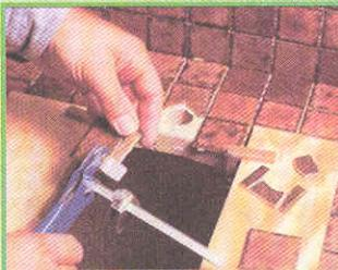
Идеальный инструмент для подгонки плиток — это клещи-резак для плитки.
