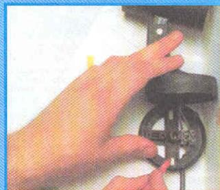
Разметка отверстия под дюбель. Прежде чем прикрепить лампы к стене, следует их полностью смонтировать.
