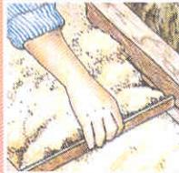
После разметки дорожки производят выемку грунта на глубину 5–10 см. Выемку заполняют песком. Уложенные по краям ограждающие планки облегчают процесс выравнивания и уплотнения песка.
