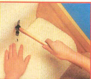
Подвернутую часть ковра снова закрепляют гвоздями, которые забивают непосредственно у края так, чтобы их шляпки плотно прижимали покрытие к проступи.
