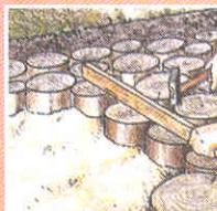
На уплотненную песчаную подушку кладут вплотную друг к другу разные по диаметру чурки, слегка пристукивая их молотком через деревянную планку.
